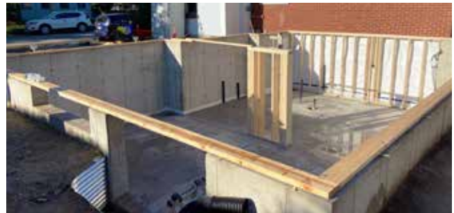
Accurate foundation pour
